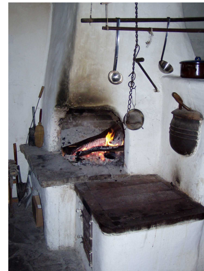
Pec na Kosence je staršího typu s topeništěm uvnitř jizby
