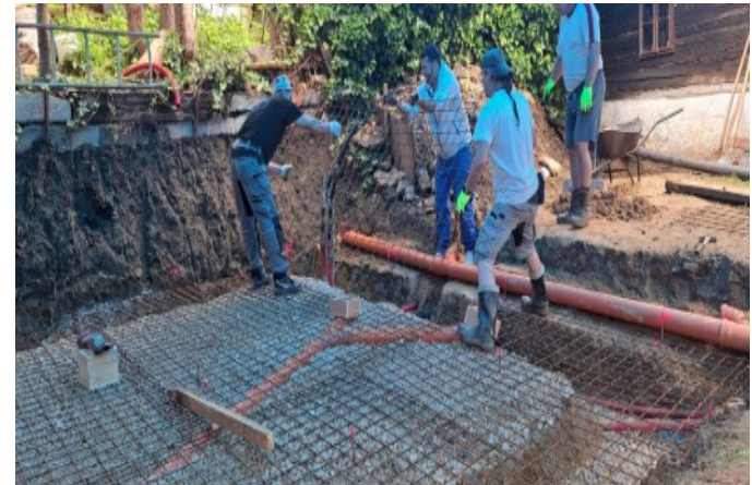
Dočištění a dokopání základů Brontosauři
