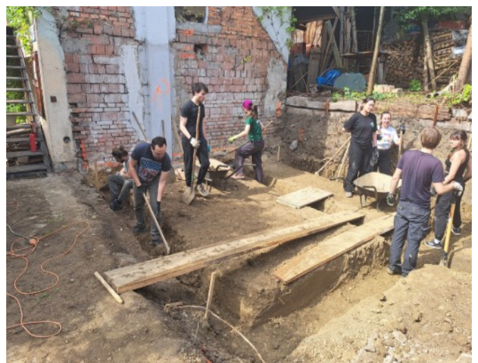
Dočištění a dokopání základů Brontosauři
