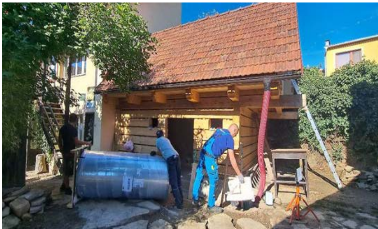
...Instalace akumulačních nádrží...
